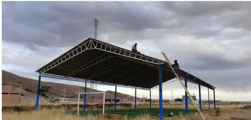
Figura 2. Aquí se muestra una cobertura con doble caída en la instalación de anemómetros
