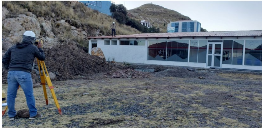
Figura 1. Nivelación con el uso del teodolito para instalación de Anemómetros el tipo de cobertura en un agua
