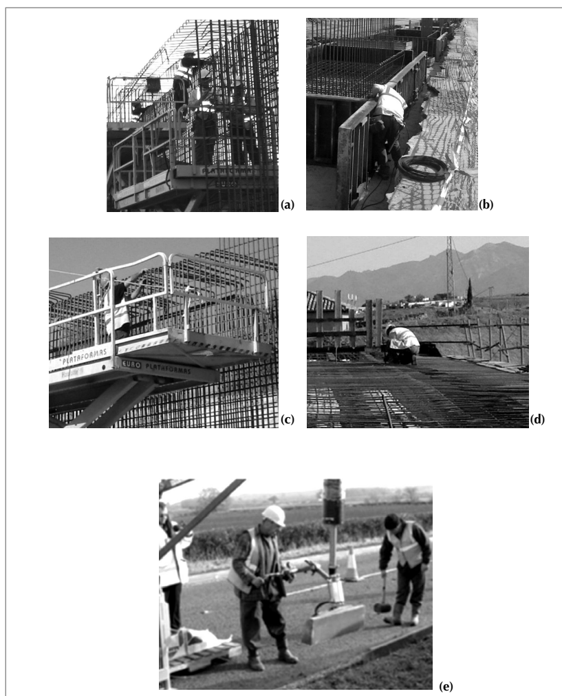
Figura 2. Puesta en obra de bordillos (Bust et al., 2005)
