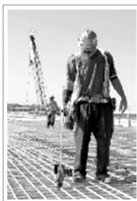
Figura 5. Herramienta para atar barras de refuerzo con mango de extensión (Albers E., 2007) Figure 5. Tools for tying up reinforcement bars, with extension handle (Albers E., 2007)
