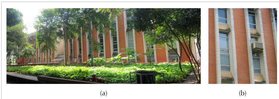
Figura 1. Entrada del edificio (sudoeste) (a) y detalle de la fachada (b)
