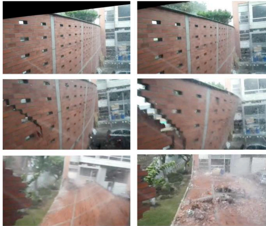
Figura 2. Secuencia del colapso
