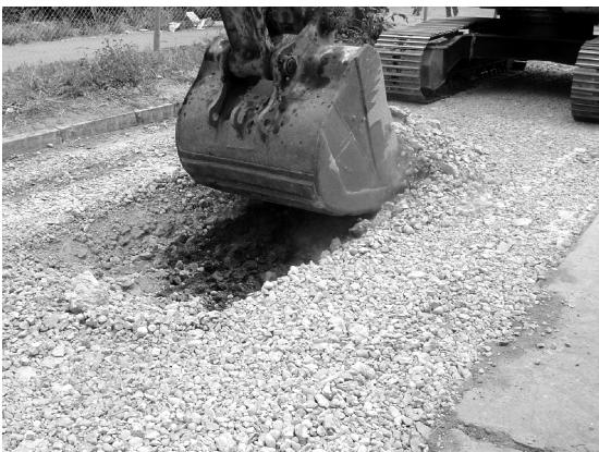
Figura 4. Retiro del material Triturado/Pulverizado en pavimento urbano, Santiago, Chile
