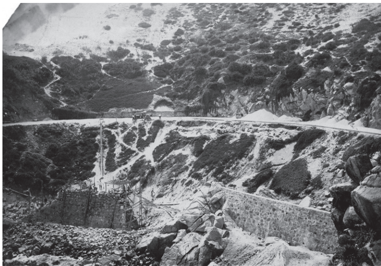
FIGURA 8 Muros de contención en obras del camino costero
