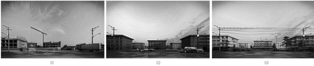
ETAPAS DE CONSTRUCCIÓN DE UN BLOQUE CORVI 1010/1020
