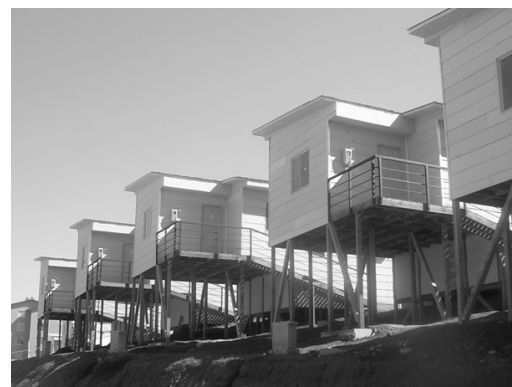
Figura 4. Viviendas tipo palafito en el conjunto Newe Ruka , Viña del Mar, AMG. En la elaboración del proyecto se intentó intervenir mínimamente el suelo, respetando la relación entre los pueblos originarios y el trato con la tierra. Fuente: Borde Urbano (2022).
