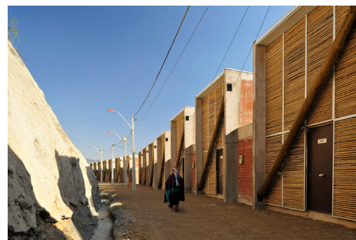
Figura 1. Conjunto habitacional Vista Hermosa, Huechuraba, Área Metropolitana de Santiago. Vista hacia el espacio entre las viviendas y el cerro Huechuraba. A su vez, se observan las fachadas principales de las edificaciones con una doble piel de coligüe y un tronco en diagonal que representa la conexión entre el cielo y la tierra. Fuente: Plataforma Arquitectura (2013).
