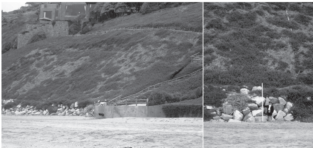
Figura N° 5 CACHAGUA. SECTOR DE MÁXIMA CONDICIÓN DE ATAQUE DEL OLAJE, DONDE SE PRODUCE EROSIÓN BASAL DEL ACANTILADO Y REMOCIÓN EN MASA ASOCIADO AL RETROCESO DEL MISMO
