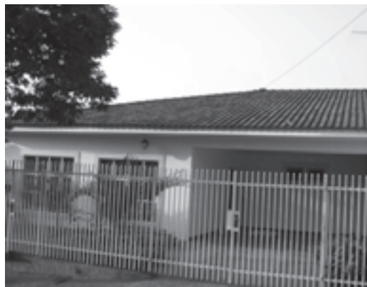
Figura Nº 11 Casa de classe média com telha cerâmica, grades vazadas e janelas amplas
