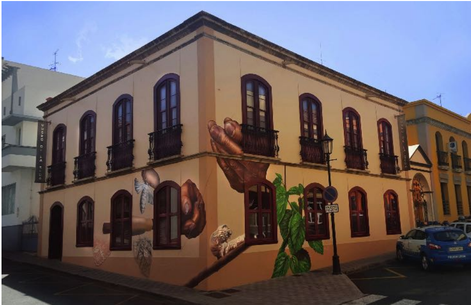
FIGURA 1 Edificio del Museo de la Seda de El Paso (La Palma, Canarias).
