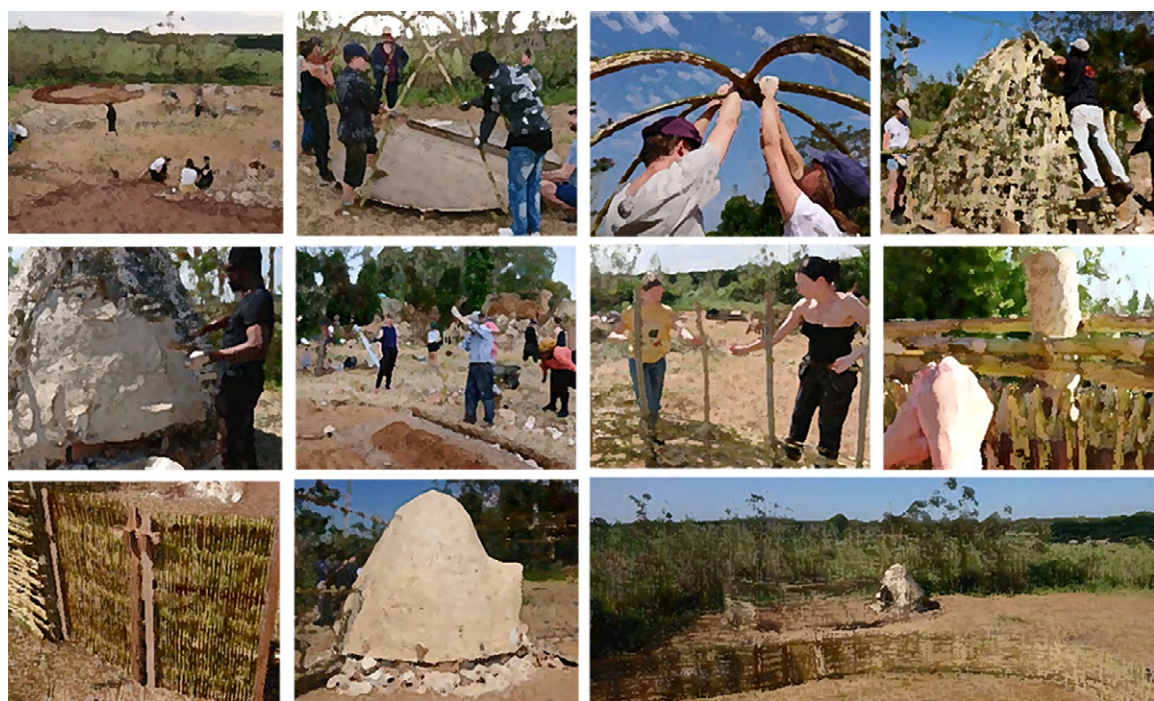
Figura 7: Construcción de un refugio para burros y gallinas en Castiglione, Italia. Imágenes de Sergio Bravo-Josephson.
